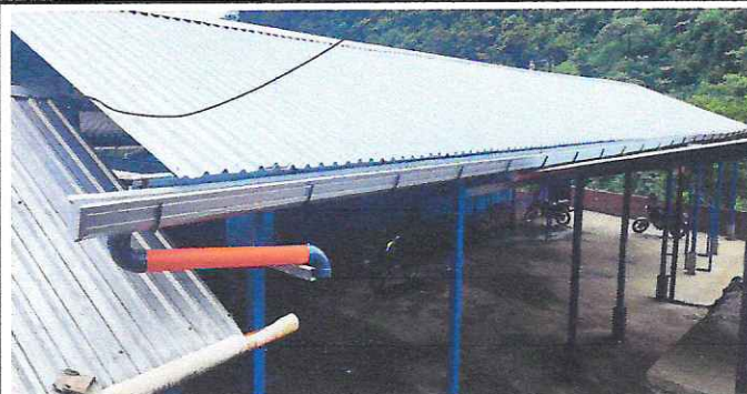
Foto 2: Instalacion de canales y bajada de agua pluvial.
