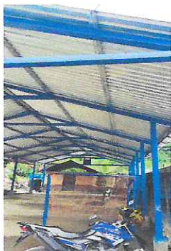
Foto 3: Mejoramiento de entechado tipo portico con estructura de techo
