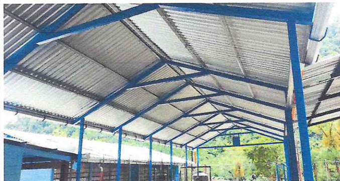
Foto1: Mejoramiento del entechado tipo portico con cubierta de lamina.
